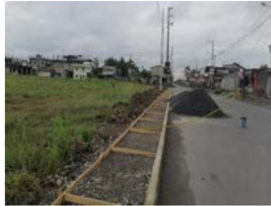
ACERAS Y BORDILLOS PARA EL RECINTO SIMÓN BOLÍVAR
