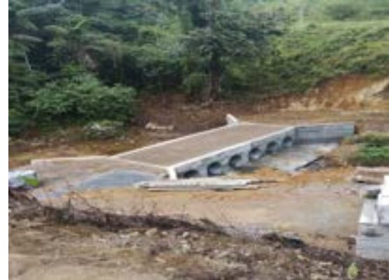
ALCANTARILLA EN BATERÍA SOBRE EL RÍO LA MONA, SAN DIMAS – RÍO GUAYLLABAMBA
