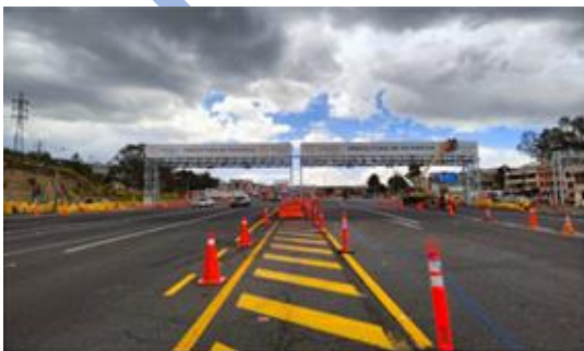
Servicio del Sistema Flujo – Libre Multi – Línea (MLFF) para el peaje de la Autopista General Rumiñahui
