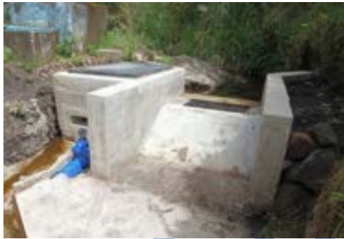
Trabajos por cogestión para el mejoramiento de la conducción del sistema de riego de la junta Ventarrón La Trabana, parroquia El Quinche, cantón Quito
