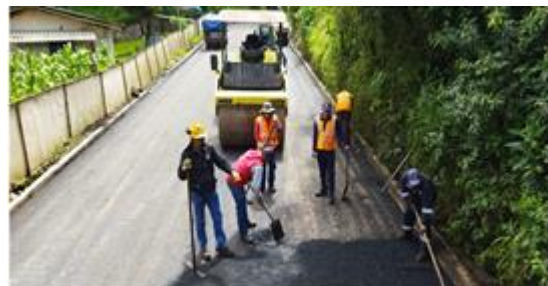
Vía Curipungo – Los Tubos
