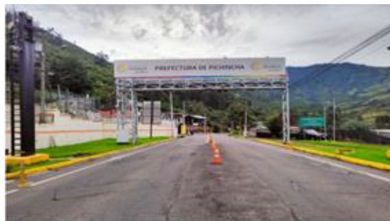
Servicio del Sistema Flujo – Libre Multi – Línea (MLFF) para el peaje de la vía Intervalles
