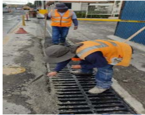
Colocación de rejillas
