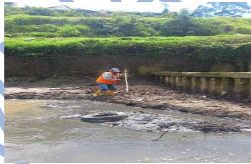
Limpieza de quebradas
