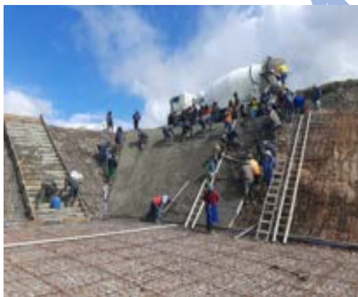
Construcción de reservorio por cogestión, sector Hierba Buena, parroquia Olmedo, cantón Cayambe
