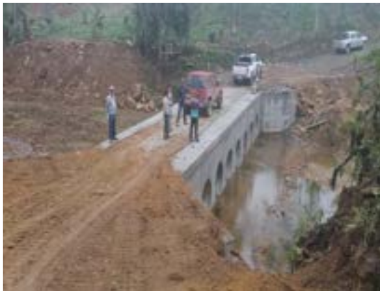
ALCANTARILLA EN BATERÍA SOBRE EL RÍO PIEDRITAS, VÍA VENTANAS – SAN FRANCISCO DE LA CAONI
