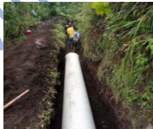
Instalación de tubería por cogestión, sistema de riego La Pirca, parroquia San José de Minas, cantón Quito
