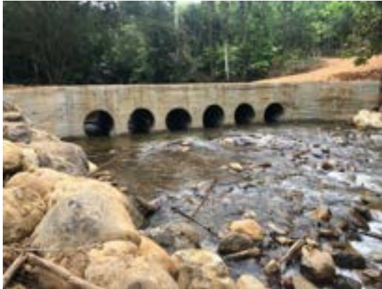
ALCANTARILLA EN BATERÍA SOBRE EL RÍO BIRINGO, VÍA LOS NARANJOS - GUAYAQUIL CHIQUITO
