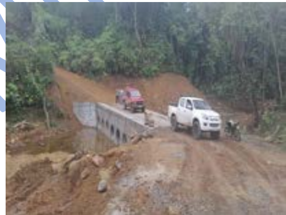
ALCANTARILLA EN BATERÍA SOBRE EL RÍO PIEDRITAS, VÍA VENTANAS – SAN FRANCISCO DE LA CAONI
