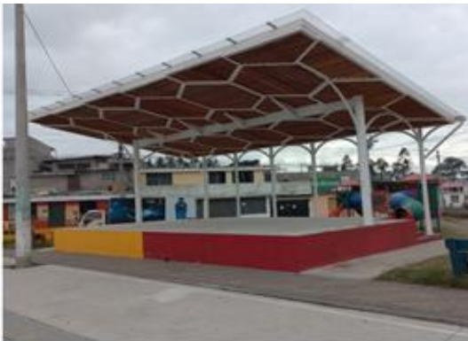
Construcción de una cubierta traslúcida con materiales mixtos, en estructura metálica y madera en el parque Central de Gualó
