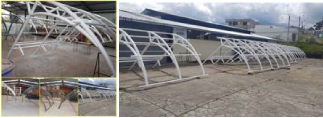
Fabricación de paradas de bus Gerencia Autopista General Rumiñahui e Intervalles
