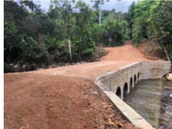
ALCANTARILLA EN BATERÍA SOBRE EL RÍO BIRINGO, VÍA LOS NARANJOS - GUAYAQUIL CHIQUITO
