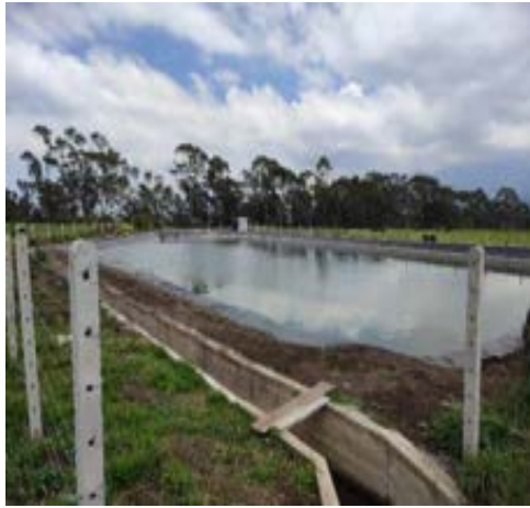
Terminación del sistema de riego Santa María y San José del Chisinche, parroquia Aloasí, cantón Mejía
