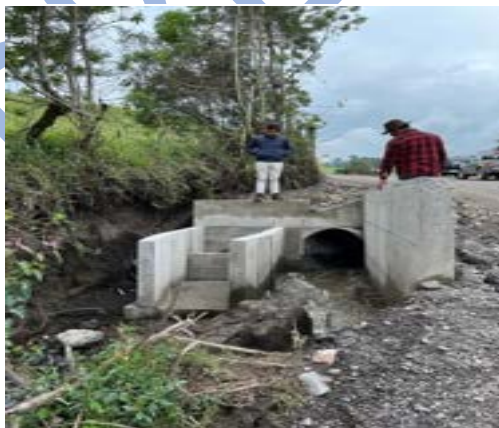
Obras complementarias de control del caudal acequia Güitig, parroquia Machachi, cantón Mejía
