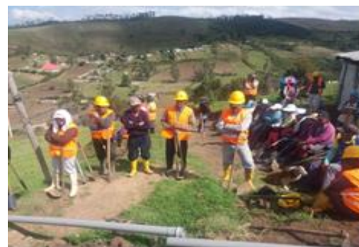
Trabajo comunitario para entubado de la conducción principal Molino Alto
