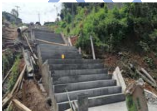
CONSTRUCCIÓN DE ESCALINATA PARA EL RECINTO 29 DE SEPTIEMBRE
