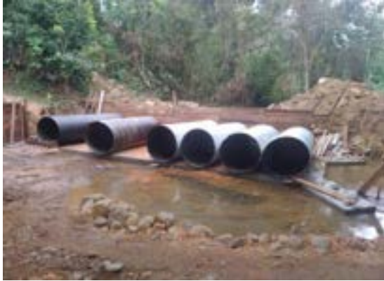
ALCANTARILLA EN BATERÍA SOBRE EL RÍO LA MONA, SAN DIMAS – RÍO GUAYLLABAMBA
