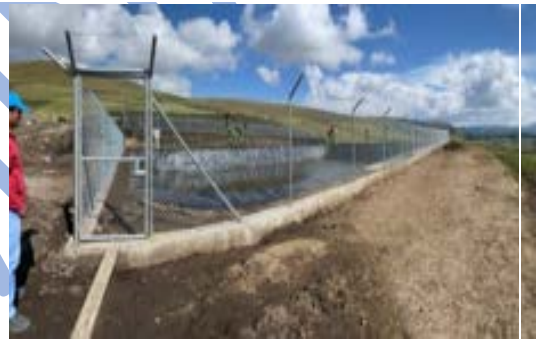
Impermeabilización del reservorio de la junta de riego Tulpashna, Monjas Bajo, parroquia Juan Montalvo, cantón Cayambe
