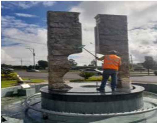
Mantenimiento de la pileta puente N°8
