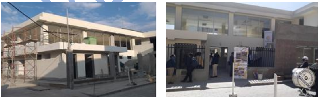
Construcción de oficinas y sala de uso múltiple del GAD Parroquial Pomasqui
