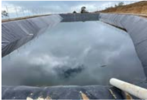
Impermeabilización del reservorio El Carmen, parroquia Checa, cantón Quito
