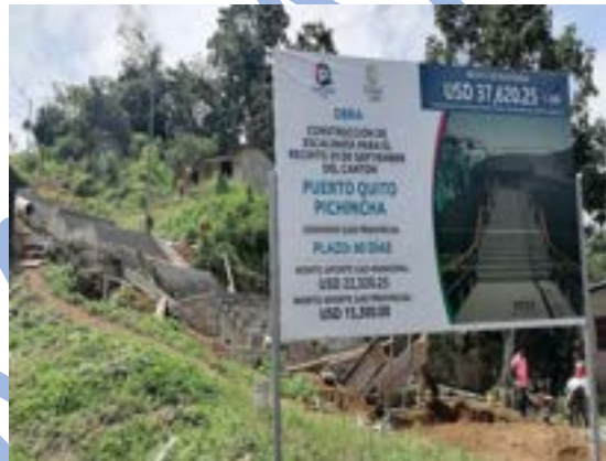
CONSTRUCCIÓN DE ESCALINATA PARA EL RECINTO 29 DE SEPTIEMBRE
