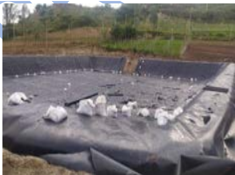
Impermeabilización del reservorio del sistema de riego acequia Piango, parroquia Puéllaro, cantón Quito
