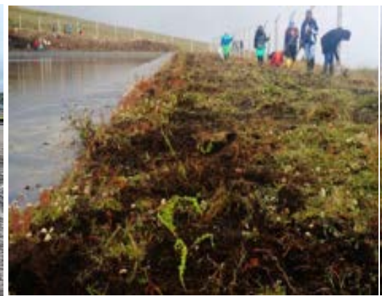
Reservorio de la comunidad Las Compañías, parroquia Cangahua, cantón Cayambe. Impermeabilización con geomembrana y reforestación en la rivera del reservorio
