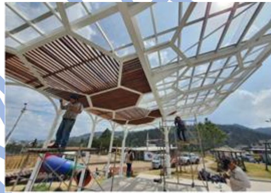
Construcción de una cubierta traslúcida con materiales mixtos, en estructura metálica y madera en el parque Central de Gualó
