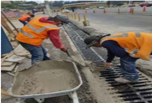
Trabajos de obra civil
