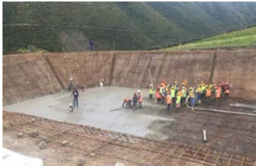
Construcción de reservorio por cogestión. Calvario La Chimba, parroquia Olmedo, cantón Cayambe
