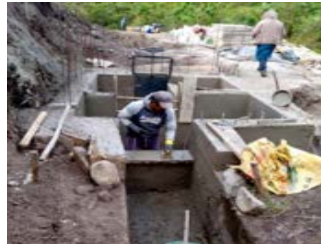
Construcción por cogestión de infraestructura de riego. Sistema de riego Calvario La Chimba, parroquia Olmedo, cantón Cayambe
