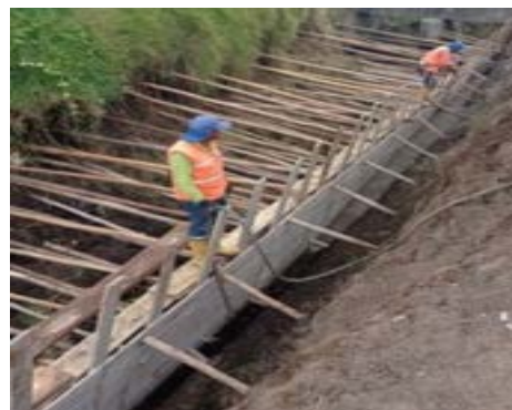
Mejoramiento del canal principal sistema de riego El Pisque, cantones Cayambe y Distrito Metropolitano de Quito.
