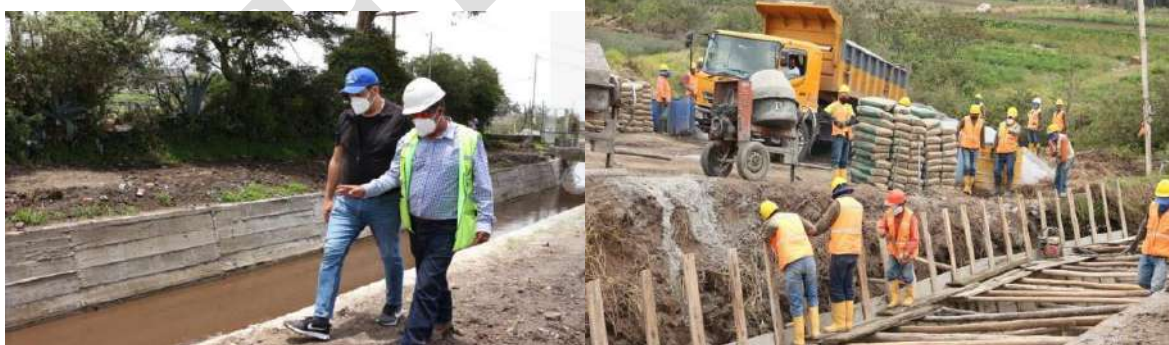
Mantenimiento del canal de riego el pisque, revestimiento canal principal zonas vulnerables, varias zonas 2018.
