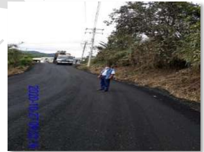
Colocación de base asfáltica, calle de acceso al CEVA, parroquia Pacto, cantón Quito
