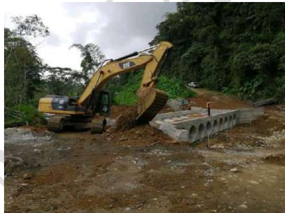
Construcción de una alcantarilla en batería sobre el estero Charapas, vía Lomas - Santa Fe.
