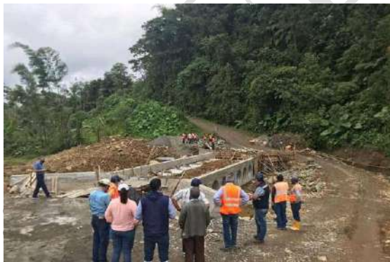
Construcción de una alcantarilla en batería sobre el estero Charapas, vía Lomas - Santa Fe.
