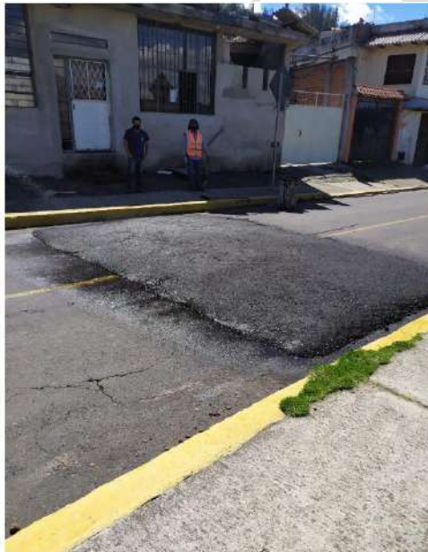
Construcción de rompe velocidades
