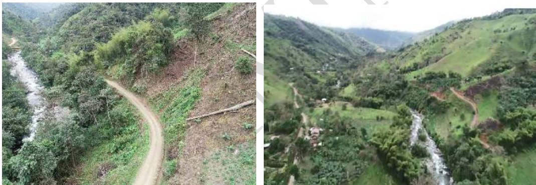
Obras preliminares realizadas: Acondicionamiento de vías de acceso
