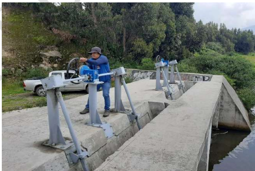
Operación y mantenimiento de aliviaderos de Control
