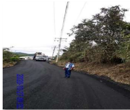
Colocación de base asfáltica calle de ingreso al CEVA en Pacto
