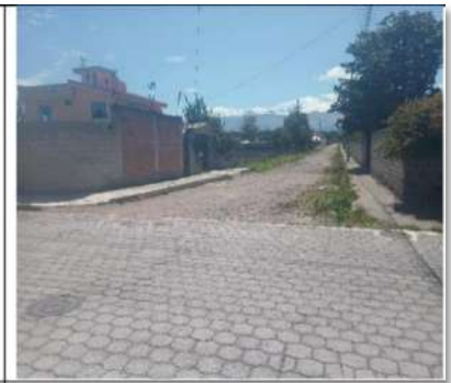
Fotografía 3. Intersección Calle Sta. Cecilia y Duchicela
