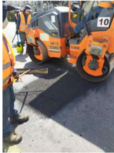
Labores de asfalto
