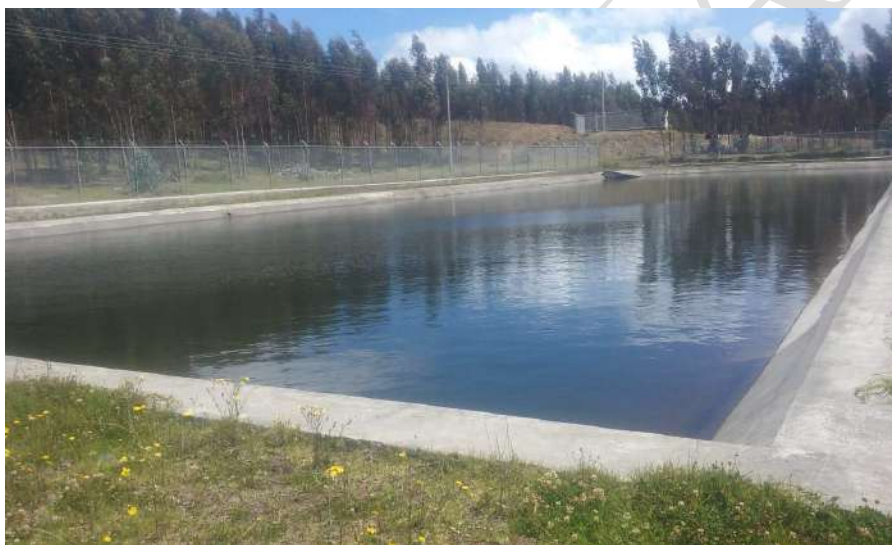
Operación y Mantenimiento Conducción Pesillo - Coinoa
