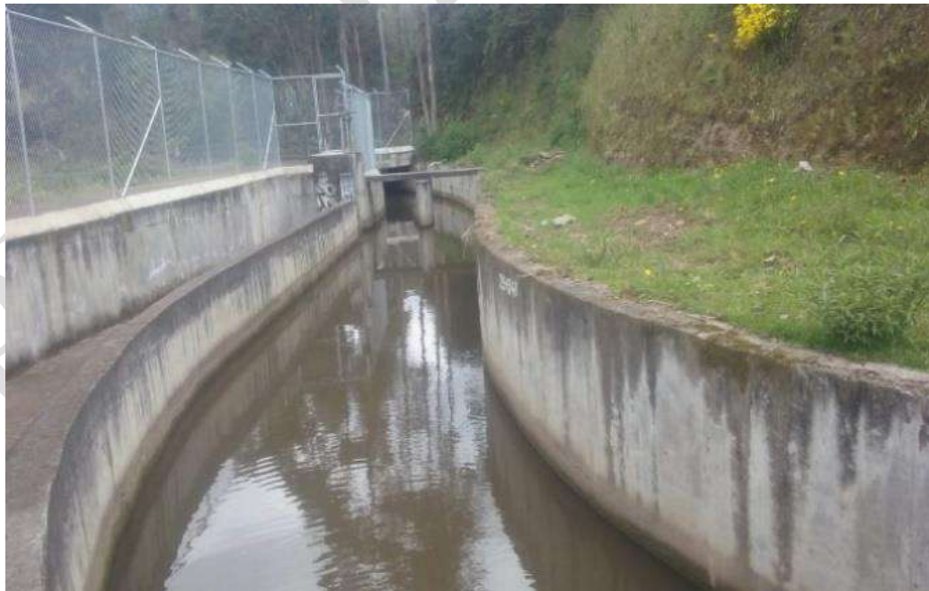
Conducción Canal Principal
