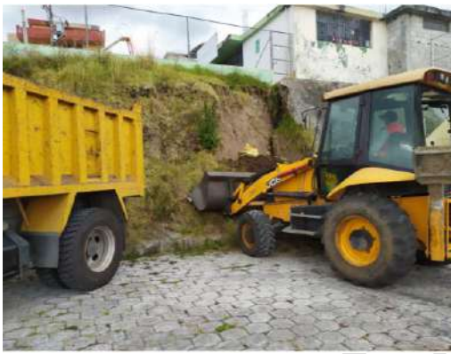
Limpieza con maquinaria
