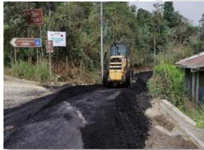
Colocación de base asfáltica, calle de acceso al CEVA, parroquia Pacto, cantón Quito
