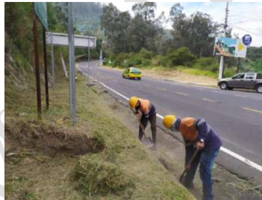
Corte y limpieza de césped
