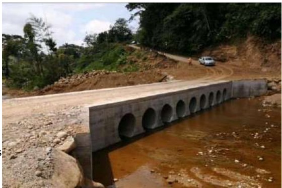
Construcción de una alcantarilla en batería sobre el estero Charapas, vía Lomas - Santa Fe.
