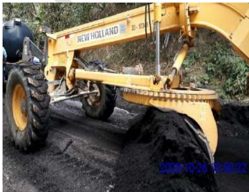
Colocación de base asfáltica calle de ingreso al CEVA en Pacto
