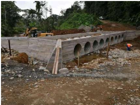
Construcción de una alcantarilla en batería sobre el estero Charapas, vía Lomas - Santa Fe.
