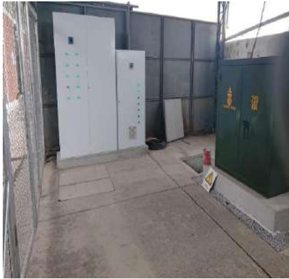
Transformador 250 KVA
